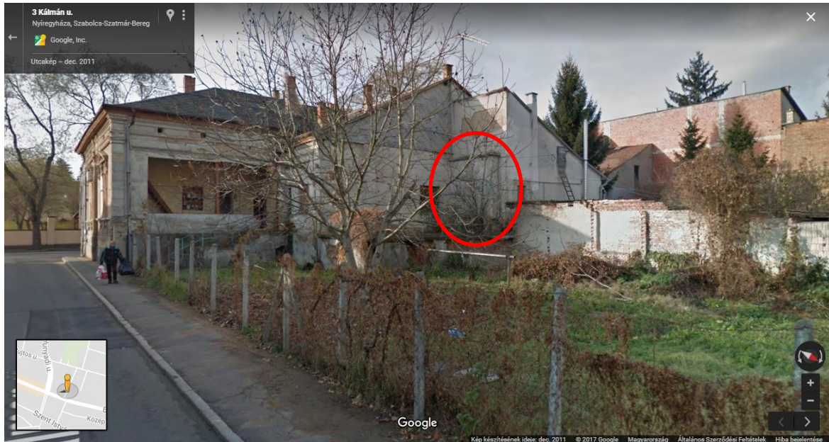
15. ábra: Bocskai utca 14. és 16. szám alatti épületek hátulról (Google 2011).
