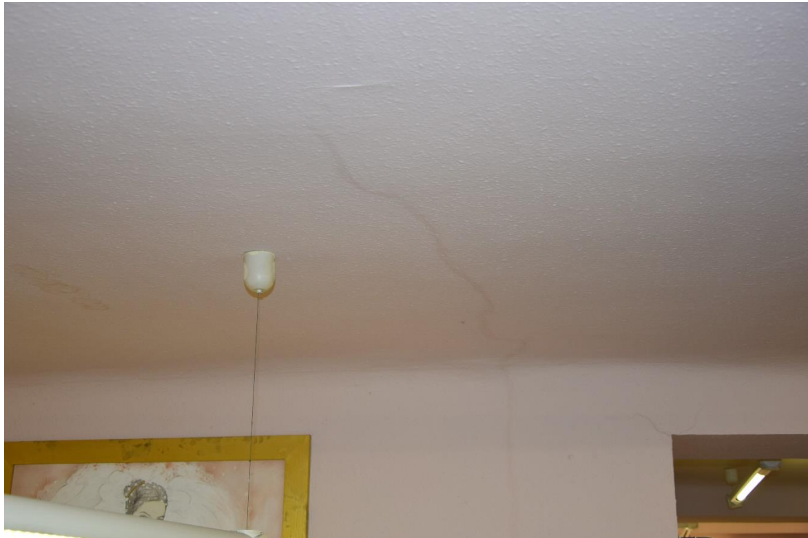
4. ábra: Az utcáfrontra merőlegesen végigmenő repedés (üzlethelyiség).
