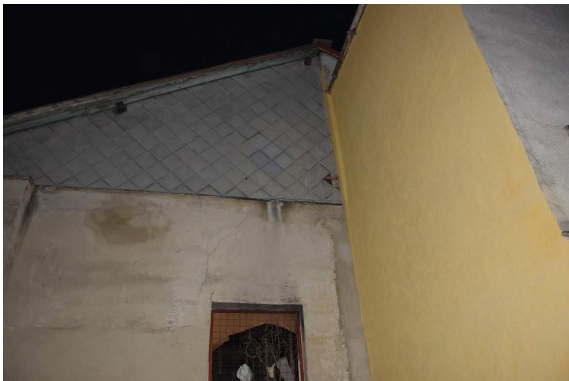
16. ábra: Elbontásra került a 14. ábrán lévő fal. A fénykép a Bocskai utca 16. szám alatti ingatlan udvara felől készült.
