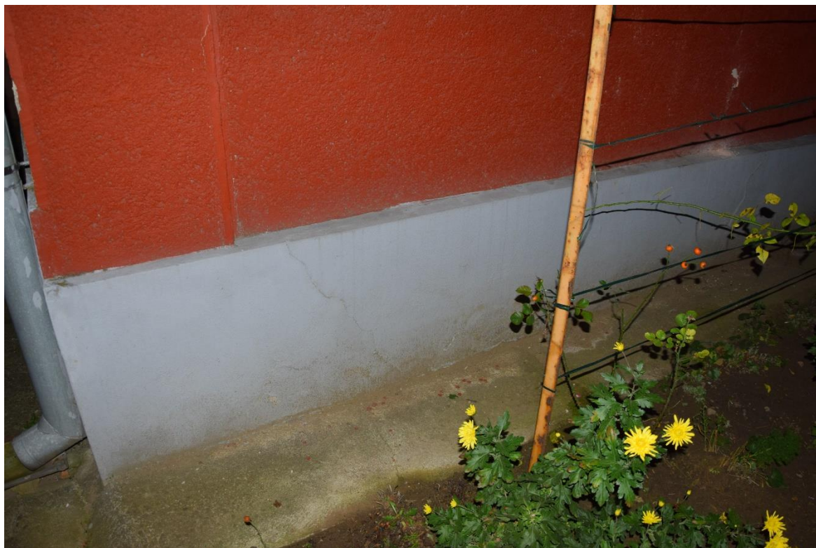
11. ábra: Tornác sarkánál kialakuló repedés a többlet terhelés miatt.
