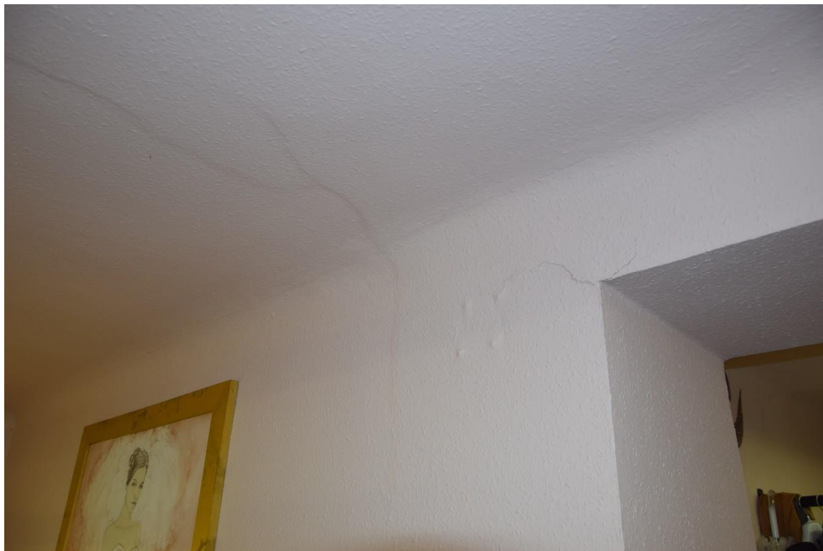
3. ábra: Az utcafrontra merőlegesen végigmenő repedés (üzlethelyiség).
